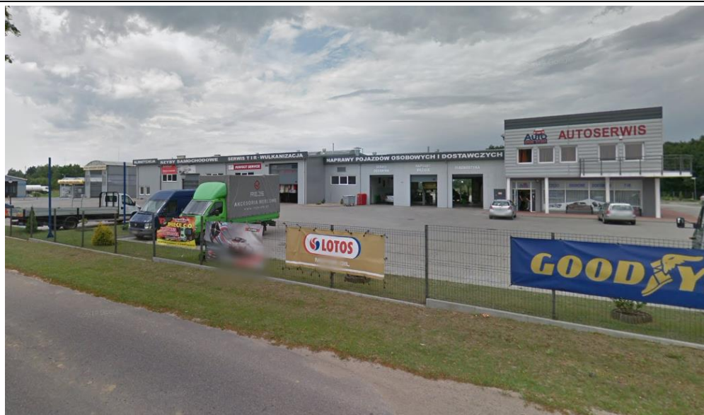
Zdjęcie 7. Autoserwis zlokalizowany po północnej stronie ul. Mleczarskiej – ptn.-wsch. część obszaru objętego mpzp
