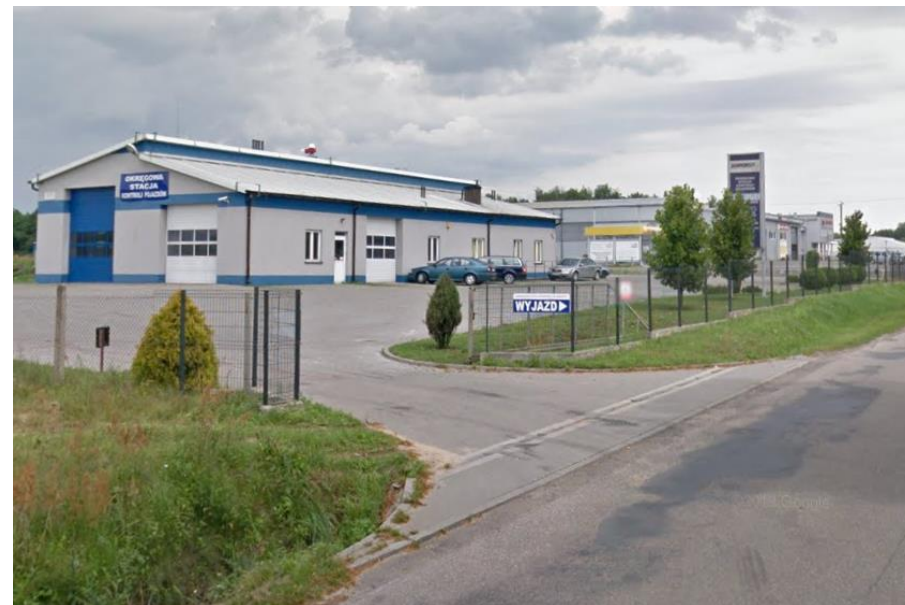
Zdjęcie 6. Okręgowa Stacja Kontroli Pojazdów zlokalizowana po północnej stronie ul. Mleczarskiej – północna część obszaru objętego mpzp
